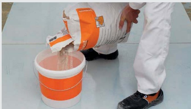
Mélanger dans un récipient propre (6,5 l d'eau/sac)
