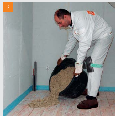
3 Répandre le mortier prêt au sol (le mélange possède, à ce stade, une humidité comparable à celle contenue dans de la terre de jardin)
