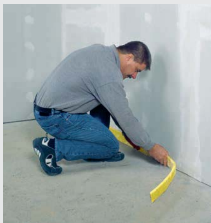
Pose des bandes résilientes périphériques
