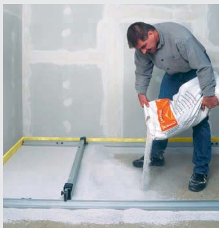
Répartition des granules entre les « digues »
