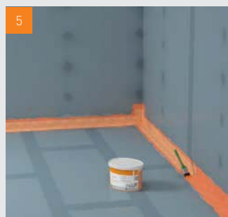
5 Puis passe de la seconde couche de SPEC sur la bande de pontage
