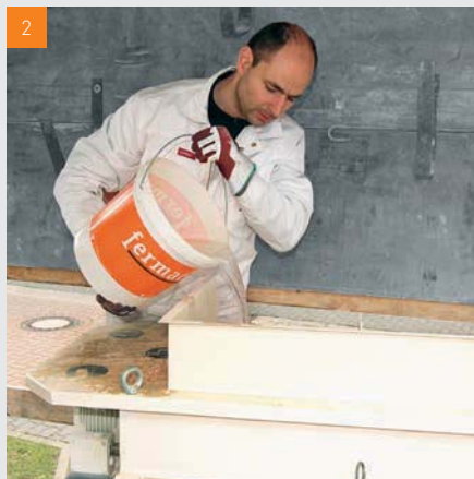
2 8 à 10 litres d'eau sont nécessaires au mélange
