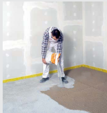
Remplir par des granules pour nid d'abeilles fermacell
