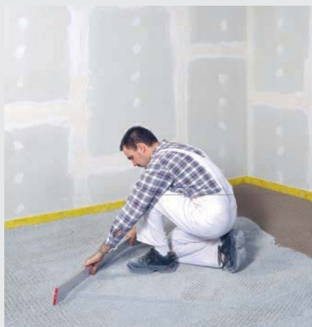
Egaliser les granules nid d'abeilles fermacell
