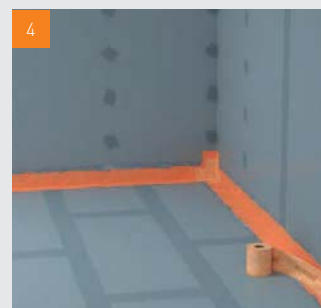
4 Marouflage de la bande de pontage dans la première couche de SPEC encore fraîche
