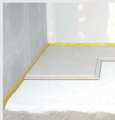
Pose des plaques de sol sur les granules (chutes de plaques disposées en guise d'îlots facilitant l'accès à la zone de travail)
