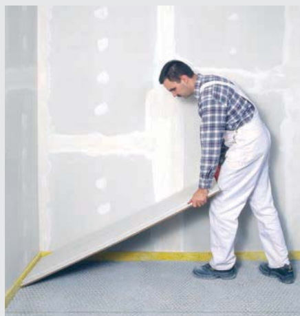
Recouvrir par les plaques de sol fermacell
