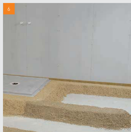
6 Attendre que le mortier d'égalisation formant les « digues » ait tiré (env. 20 minutes)
