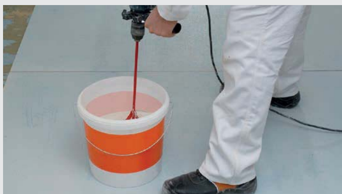
Obtenir un mélange homogène, sans grumeaux, à l'aide d'un malaxeur utilisé à bas régime
