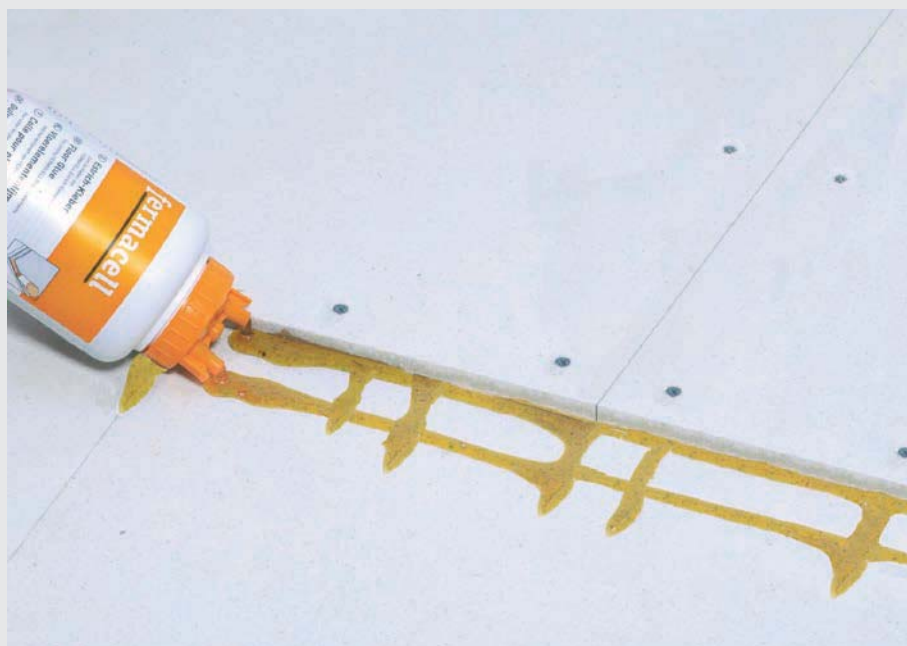
Schéma de pose troisième couche
