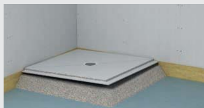
Mode de pose A : Ragréer la zone du receveur de douche avec le mortier d'égalisation fermacell sur une hauteur équivalente au niveau supérieur du corps de siphon. Après séchage du mortier d'égalisation, positionner le receveur de douche
