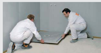
Mode de pose B : Ragréer toute la surface de la pièce avec le mortier d'égalisation fermacell sur une hauteur équivalente au niveau supérieur du corps de siphon. Après séchage du mortier d'égalisation, positionner le receveur de douche
