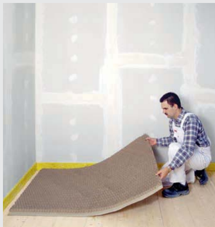
Pose des éléments nid d'abeilles au sol
