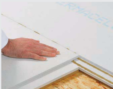
Recouvrir la battue à l'aide de la seconde plaque afin d'obtenir un collage parfait
