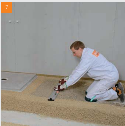
Le mortier d'égalisation répandu entre les « digues » est ensuite égalisé à l'aide de la règle
