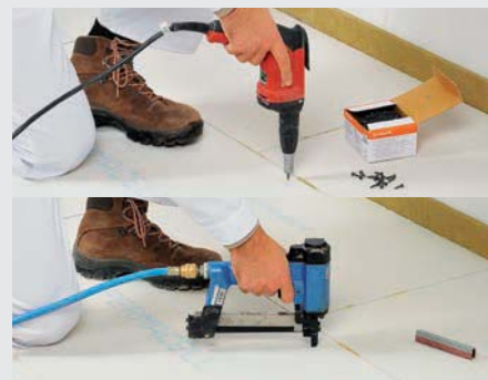
Fixer mécaniquement les plaques entre elles à l'aide de vis autoperceuses ... ou d'agrafes dans un délai de 10 minutes au plus suivant le collage
