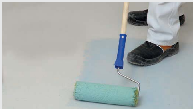
Préparer le support par impression d'un primaire
