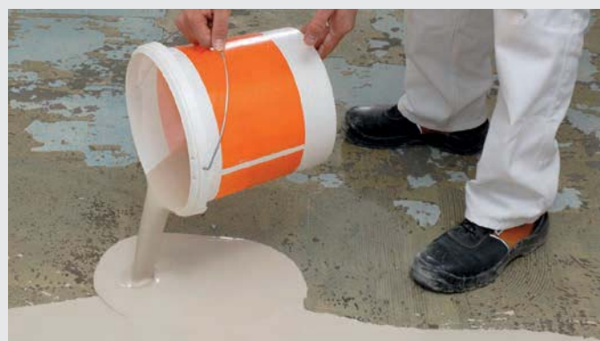
Répondre le mélange et le lisser si nécessaire
