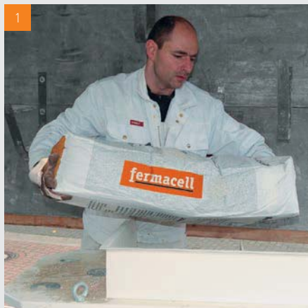
1 Verser le contenu complet d'un sac dans un récipient adapté
