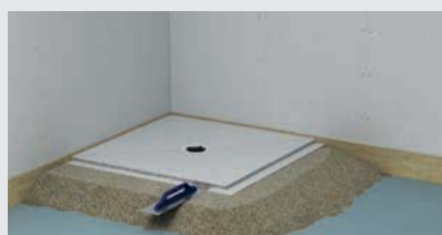
Mode de pose A : Créer ensuite une digue de 200 mm de large autour du receveur en s'alignant sur la battue de celui-ci. La digue donne la hauteur finale du ragréage pour le reste de la pièce
