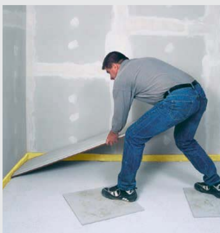
Pose des plaques de sol sur les granules (chutes de plaques disposées en guise d'îlots facilitant l'accès à la zone de travail)
