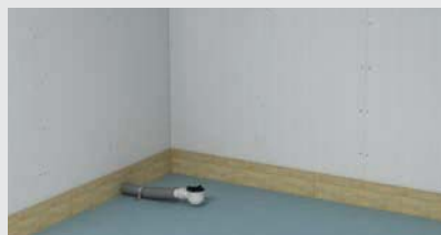
Tracer l'emplacement du receveur de douche, puis placer le corps de siphon
