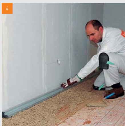
4 La première « digue » est dressée et nivelée
