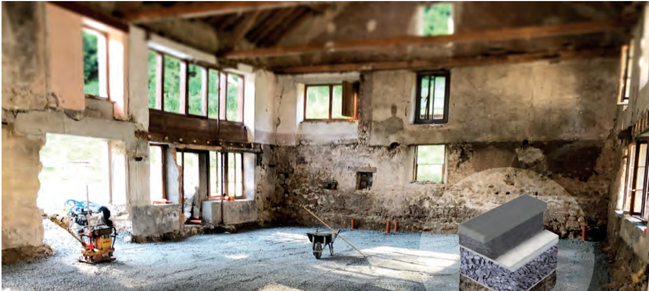
Rénovation d'une maison villageoise
